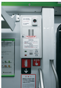
非常通報器・非常停止ボタン
